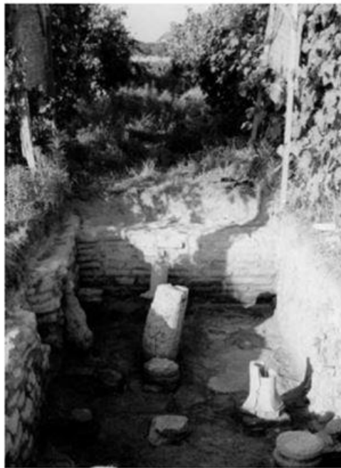
Fig. 2 – Vano, sottostante al pavimento, in cui circolava l'aria riscaldata. Visibili i resti delle colonnine di sostegno del pavimento.
